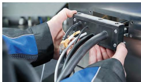
In alto, il sistema di ingresso cavi VarioPlate; in basso, il supporto per tubi corrugati CTCC IWS.
