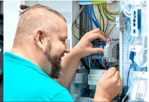
STEP POWER per l'automazione degli edifici: con un design stretto e a basso profilo e la tecnologia di connessione Push-in per un avvio facile e veloce.
