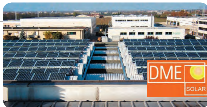
Realizzazioni DME SOLAR.
